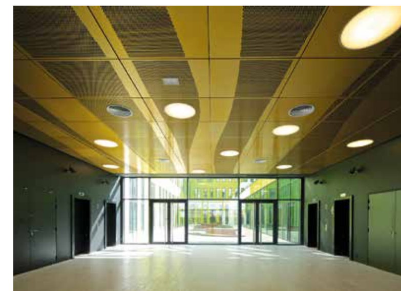
Cassettes Doria pour le plafond du projet Cœur d'Orly par l'agence Wilmotte & Associés.
